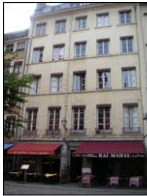
|11| 10 rue Saint-Jean vers 2 place du Petit Collège
